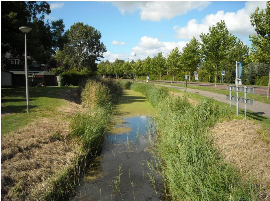
FIGURA 12: FOSSO DI LAMINAZIONE/INFILTRAZIONE IN CONTESTO URBANO CON VEGETAZIONE IGROFILA DI SPONDA.
