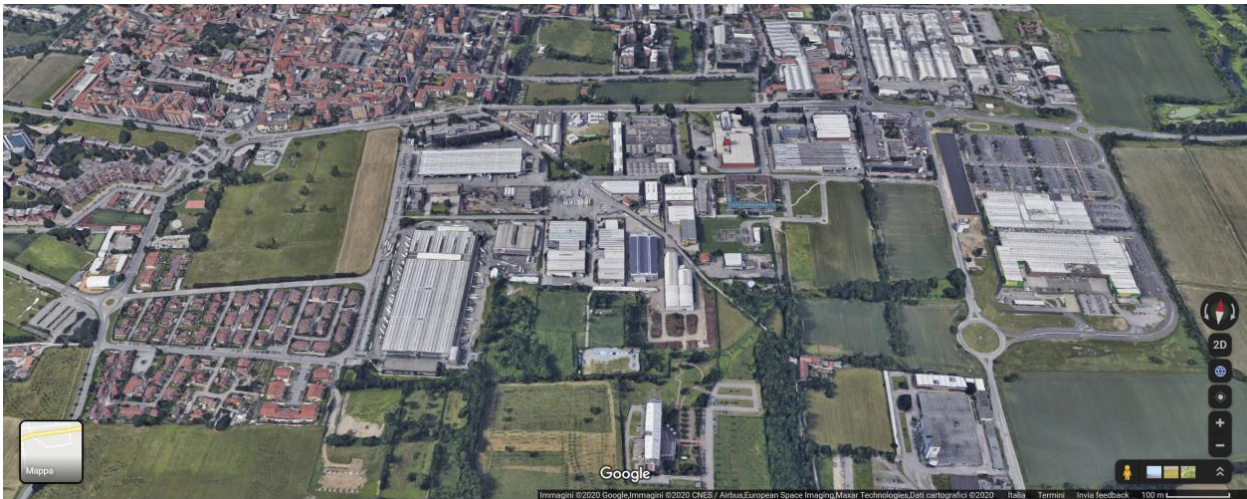
Fig. 35 Veduta area dell'area industriale. Fonte: Google 2020
