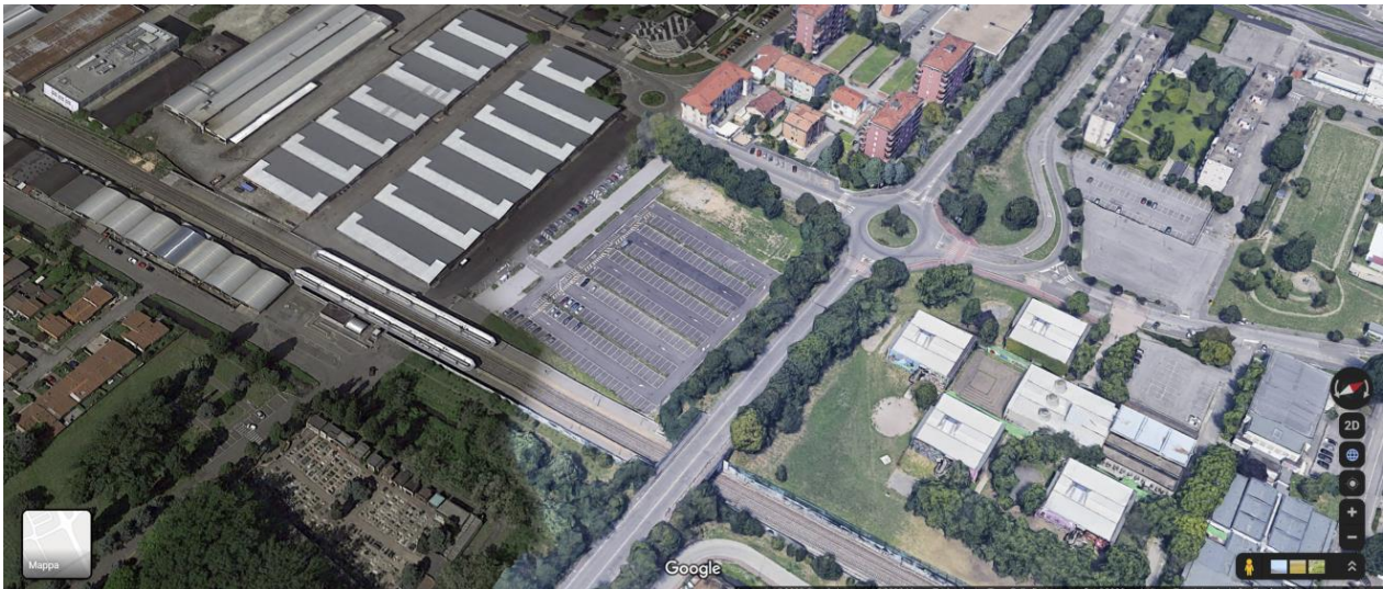
Fig. 25 Veduta aerea del parcheggio d'interscambio della stazione di Trezzano Sul Naviglio F.S. Fonte: Google 2020
