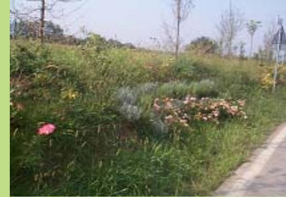
Esempio di barriera antirumore in rilevato lungo strada, con inserimento di vegetazione ornamentale e di consolidamento.
