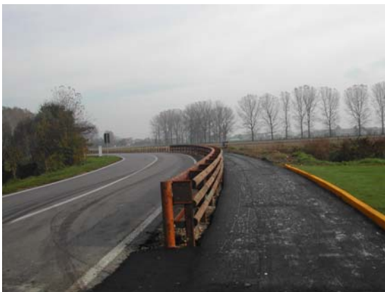
Una curva particolarmente pericolosa con palificate rinforzate in comune di Tribiano Foto di C. Boca
