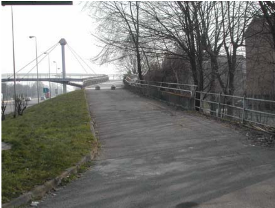
Ponte sul viale Forlanini Foto di C. Boca
