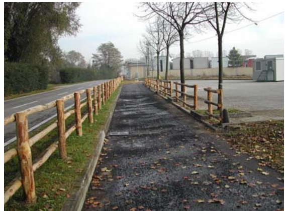
Pista che collega il municipio al cimitero, in Comune di Tribiano, ad opera finita Foto di C. Boca
