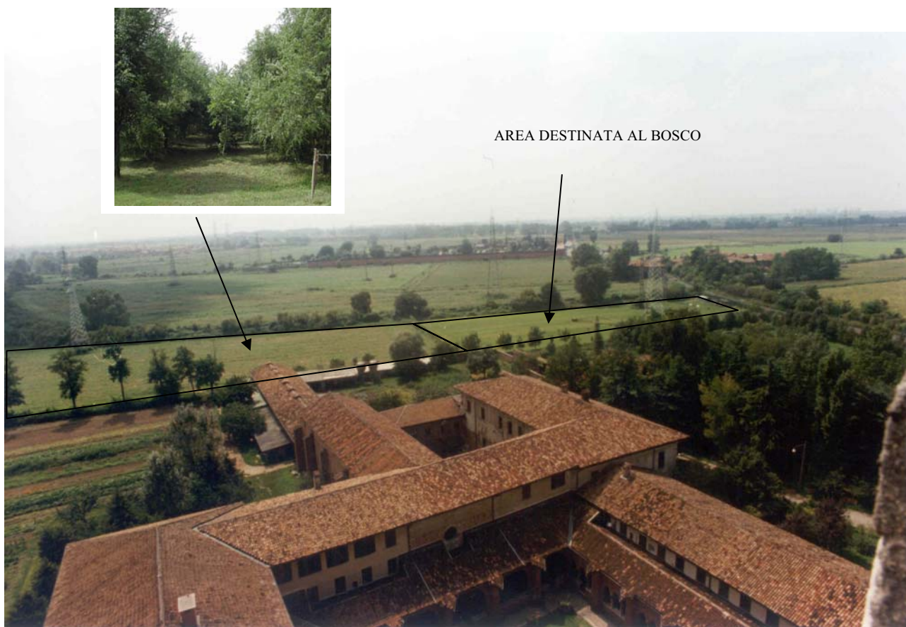
Il complesso dell'Abbazia di Chiaravalle Elaborazione di M. Cont
