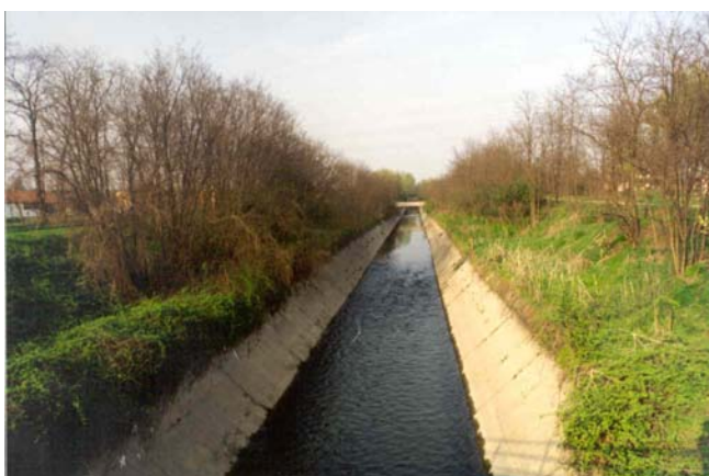
Un tratto del Canale Scolmatore di Nord-ovest Foto di M. Sparta
