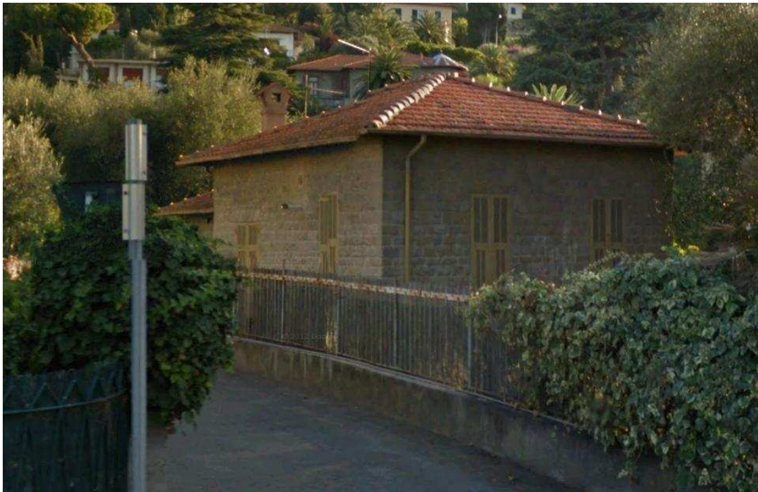
Vista della casa del custode
